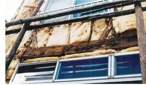
結露で腐食した繊維系の断熱材
